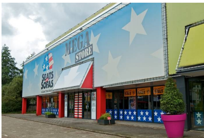
Gevelbedekkende reclame Lylantsebaan (voldoet niet aan bovenstaande voorwaarden)
