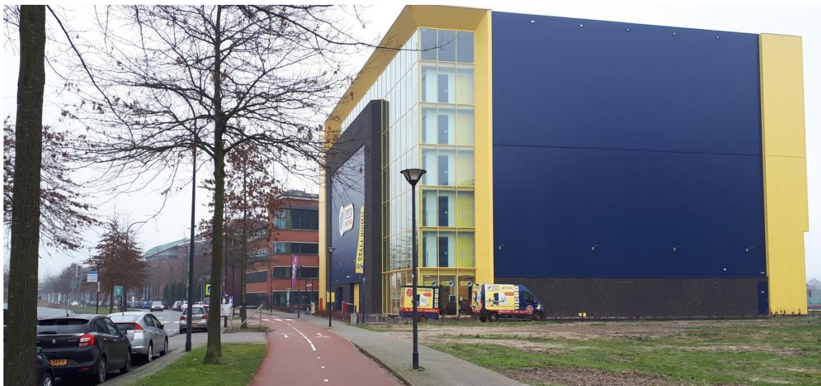
foto 7: optionele verplaatsing van inrit langs zijkant pand naar achterzijde (zie busje en aanhanger)
