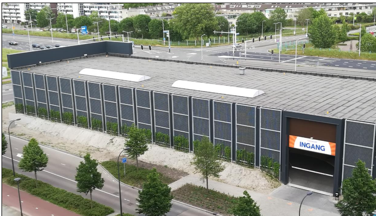
Afbeelding 1: Huidige situatie: foto van dakreclame zoals op het dak geplaatst (bron: foto bewoners).
