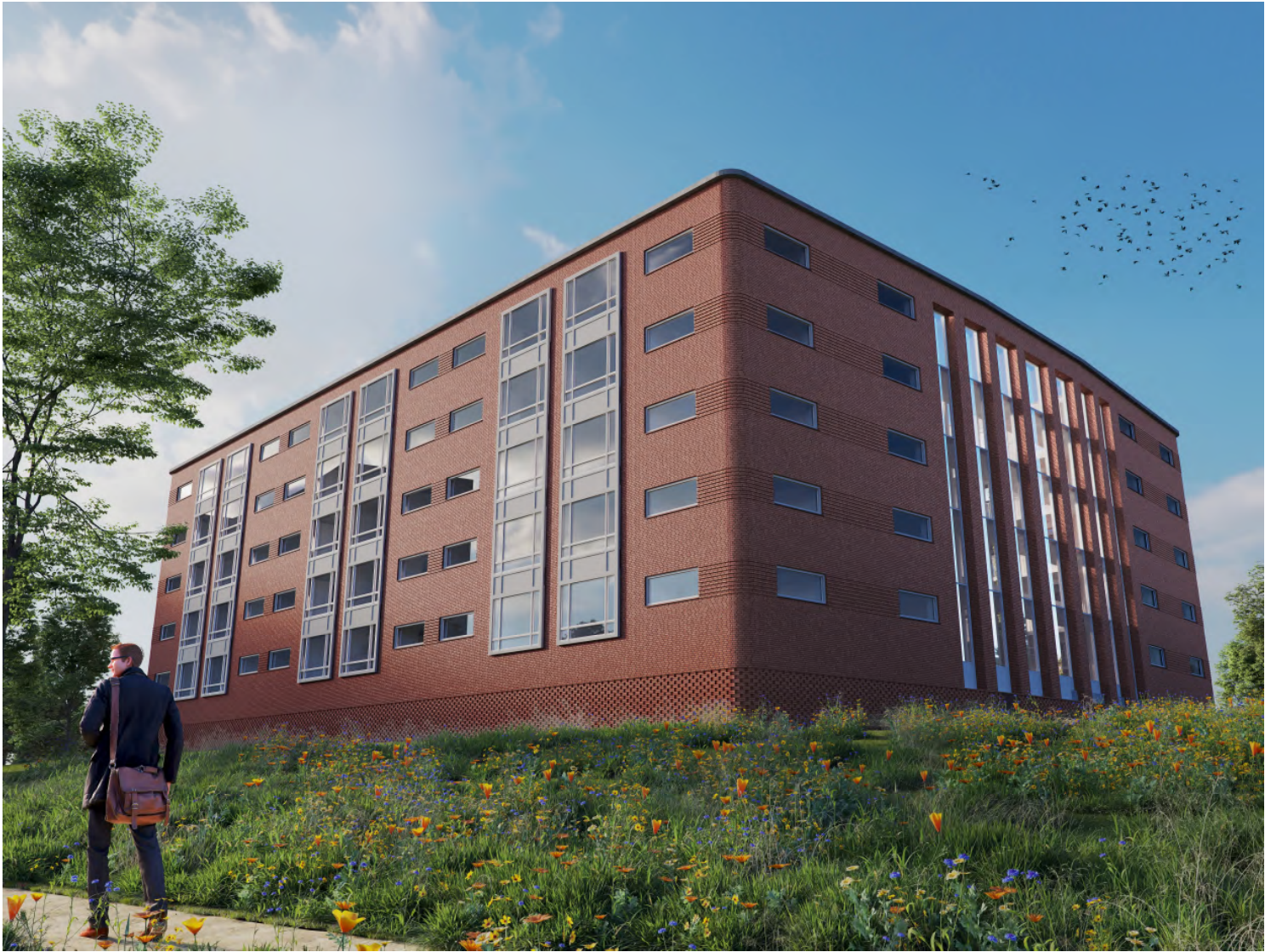
Achterzijde aan Abram van Rijckevorselweg
